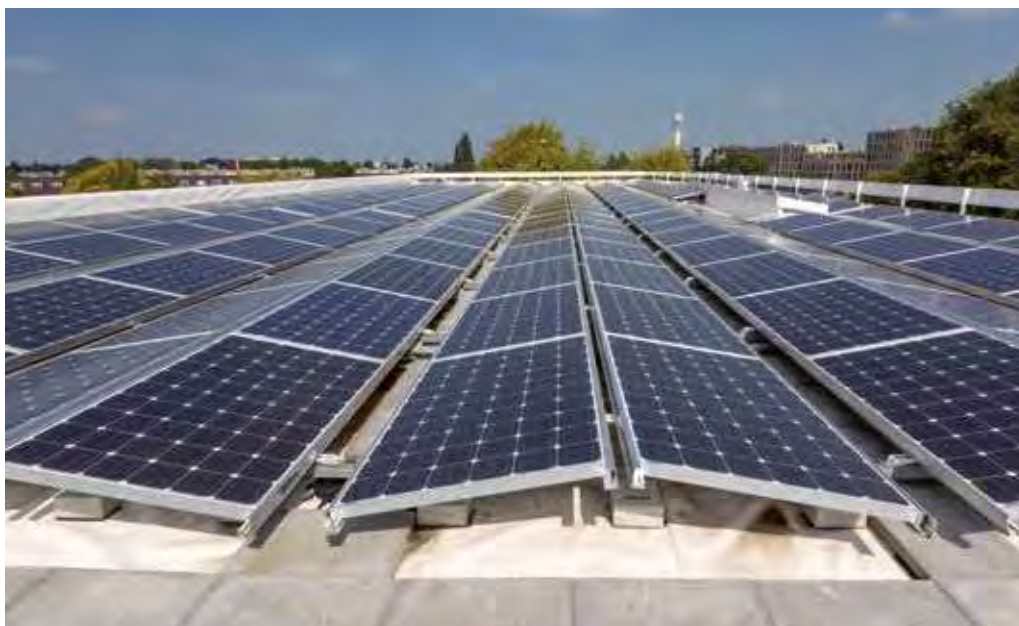
DE KLIMAATNEUTRALE SCHOOL PLEIN OOST AAN HET VAN ZEGGELNPLEIN, EEN VAN DE VIJFTIEN KLIMAATNEUTRALE SCHOLEN UIT HET VOORLOPERSPROJECT VAN HET RVO, IS VOORZIEN VAN VIJFHONDERD ZONNEPANELEN OP HET DAK.
